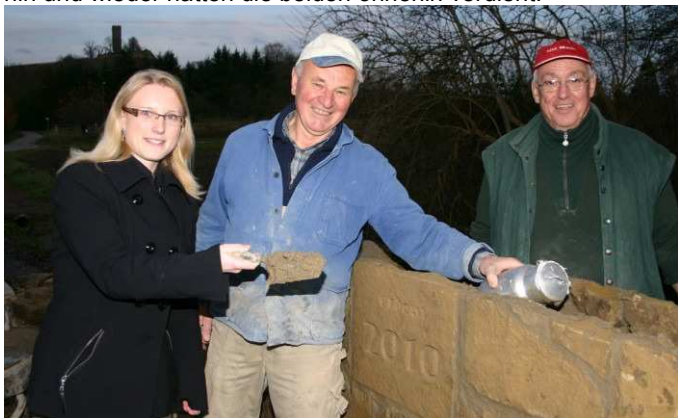
Grundsteinlegung der neuen Sandsteinmauern an der Kohlbachbrücke: Bürgermeisterin Sarina Pfründer mit den ehrenamtlichen Helfern Wolfgang Kern und Gerd Wagner.
