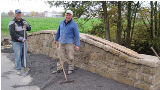
Gerd Wagner und Wolfgang Kern bei der Arbeit. Sie errichteten ehrenamtlich zwei neue Sandsteinmauern zur Einfassung der Kohlbachbrücke in der Weilergasse.
