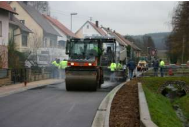
Aufbringen der Abschlussdecke kurz vor Weihnachten
