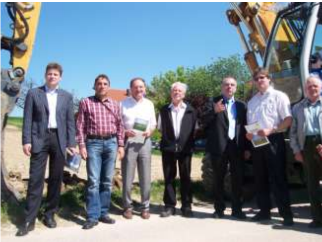
Bürgermeister Roth mit Behördenvertretern beim ersten Baggerbiss für das Rückhaltebecken westlich des Baugebietes „Kümbacher Weg“
