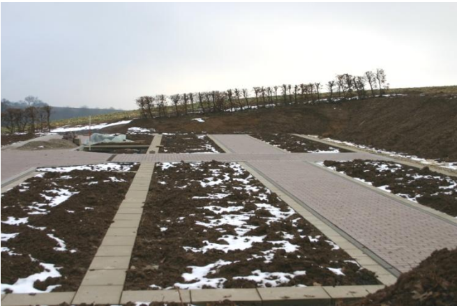
Bis zum Wintereinbruch konnten die Bauarbeiten weitgehend abgeschlossen werden
