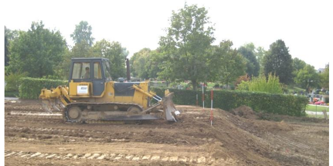
Im Frühherbst wurde mit der Herstellung der Planie begonnen.
