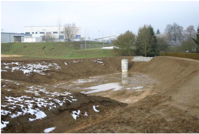
Rückhaltebecken bei der Firma Blanco
