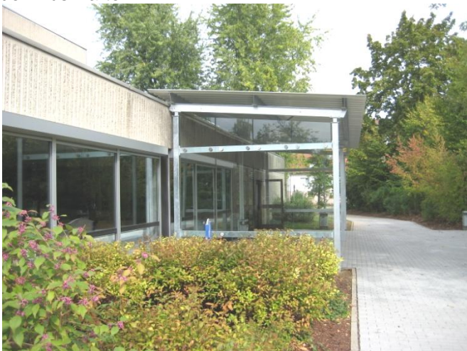
Der überdachte Eingangsbereich der Ravensburghalle
