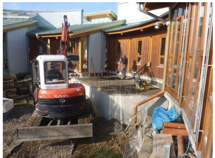
Weitgehend abgeschlossen sind die Betonarbeiten an der Bodenplatte
